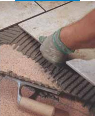
Sovrapposizione di un rivestimento in monocottura su marmette esistenti
