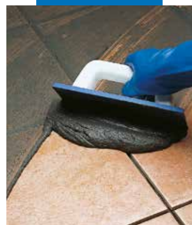
Stuccatura di monocottura con spatola
